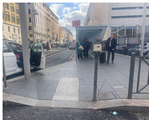
Fig.20 pensilina fermata taxi stazione Termini
