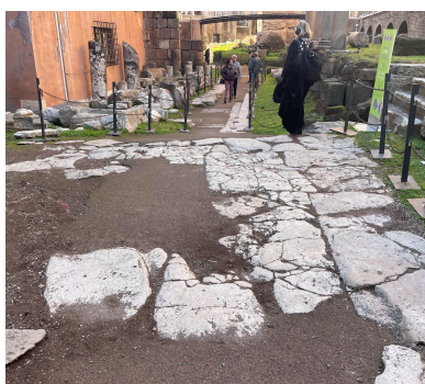
Fig.8 pavimentazione irregolare dentro il Teatro di Marcello
