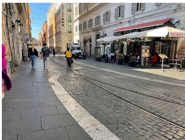
Fig.1 segnalazione tattile indicando i binari del tram
