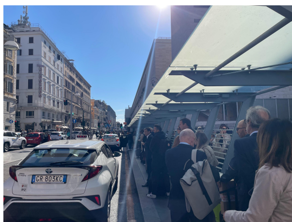
Fig.18 pensilina fermata taxi stazione Termini
