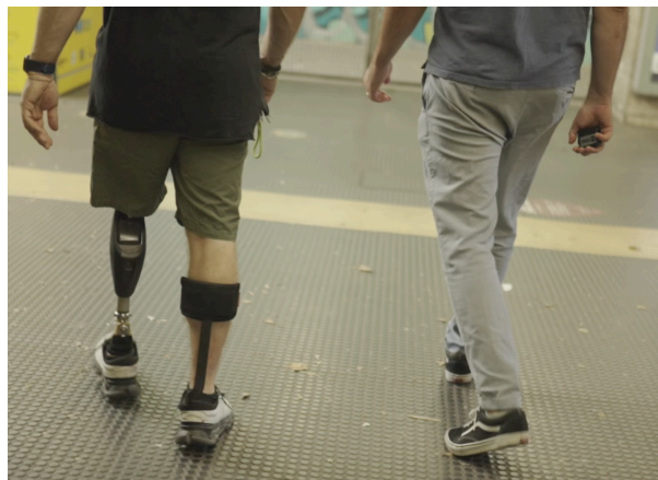
Fig.5 LOGES interno stazione Basilica S. Paolo
