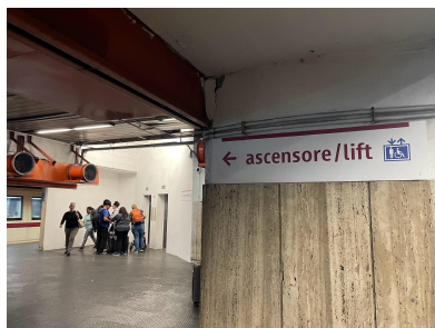
Fig.4 ascensori piano binari stazione San Giovanni - no LOGES
