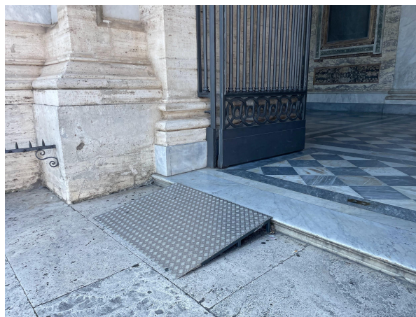
Fig.13 rampa verso l'atrio della Basilica San Giovanni
