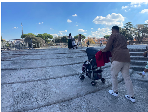
Fig.12 rampa verso la facciata della Basilica San Giovanni
