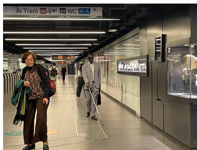
Fig.5 percorso in LOGES interno stazione San Giovanni
