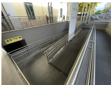
Fig. 10 rampe in direzione dei sottobinari stazione Ciampino
